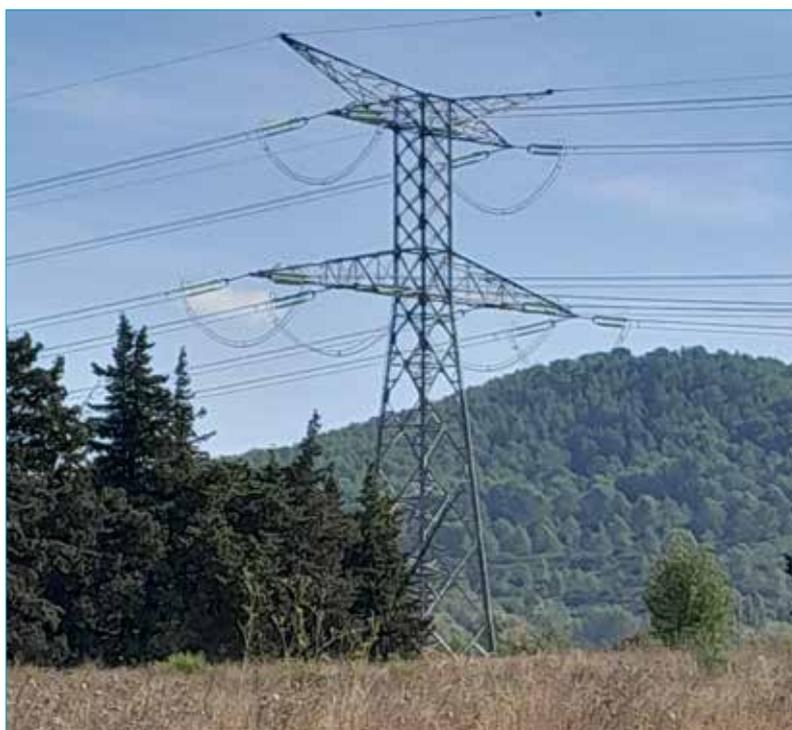
Exemple d'une ligne aérienne construite avec des pylônes de type F44
