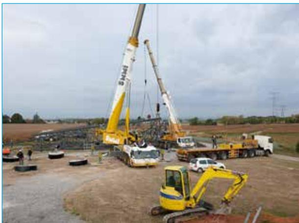
Exemple d'une plateforme de montage et de levage d'un pylône
