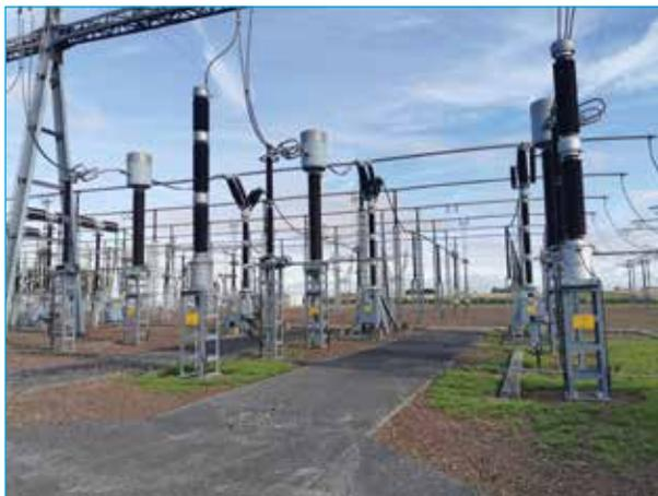
Exemple de cellules-lignes dans un poste 400 000 volts
